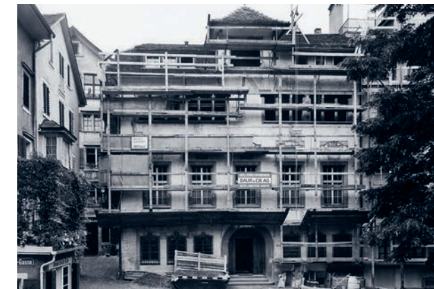
Das Lavaterhaus, Probelokal des Kirchengesangvereins, hier in Renovation 1959
